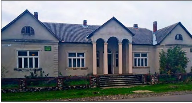
Будівля, в якій невдовзі розташується Музей природних та культурних цінностей історичної Мараморощини (с. Широкий Луг Тячівського району Закарпатської області)
