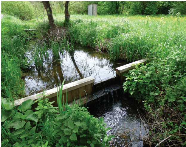
Рис. 3. Гідроспоруда для підняття рівня ґрунтових вод
