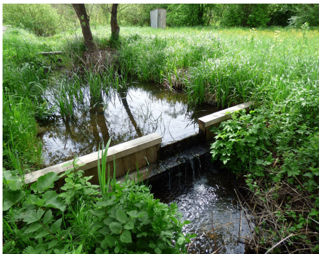
Рис. 3. Гідроспоруда для підняття рівня ґрунтових вод
